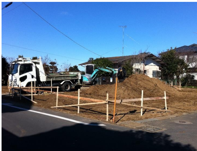
基礎工事開始
